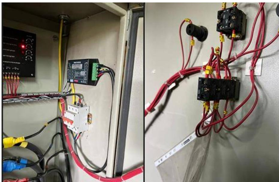
**DATACENTER:** realizamos inspección a la red eléctrica, en el cual encontramos dos tableros de red normal y uno de red regulada, los cuales se encuentran técnicamente funcionando, pero con difícil acceso ante una emergencia y/o mantenimientos, los mismos no cuentan con marcaciones de los circuitos en los mismos por lo cual es difícil identificar que alimenta cada circuito.
