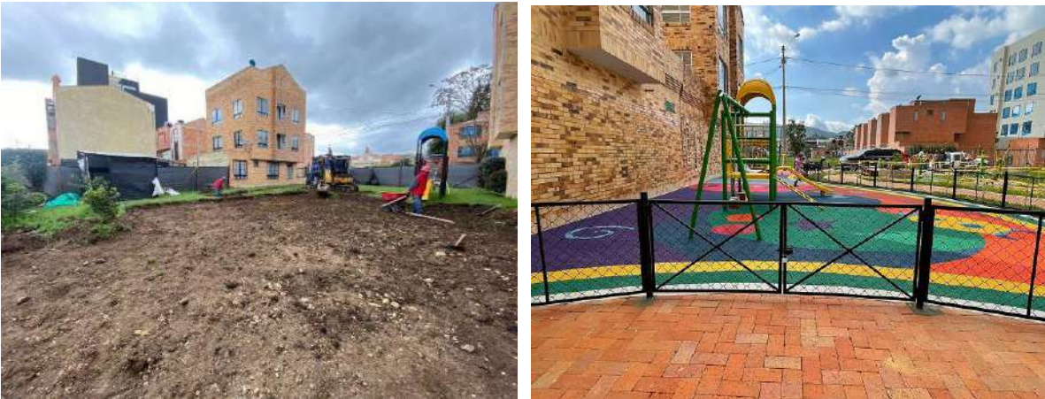
Foto: Construcción Espacio Público – Parque Bachué
