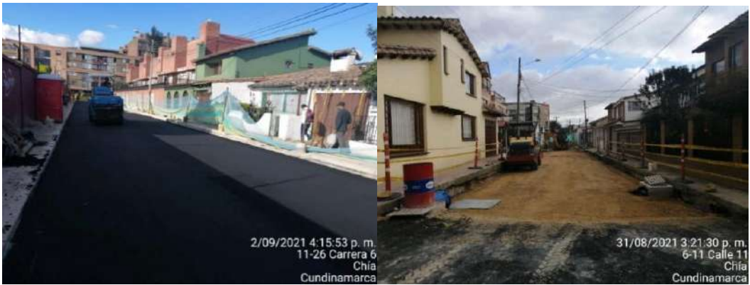
Foto: Mantenimiento vial intervención de estructura y capa de rodadura
